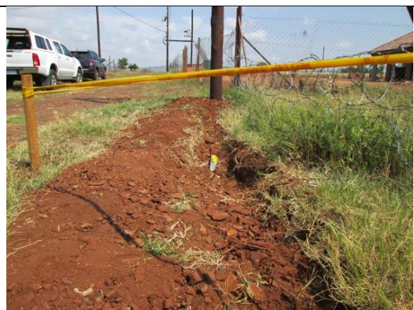
Fig 3. Trench, longitudinal view
