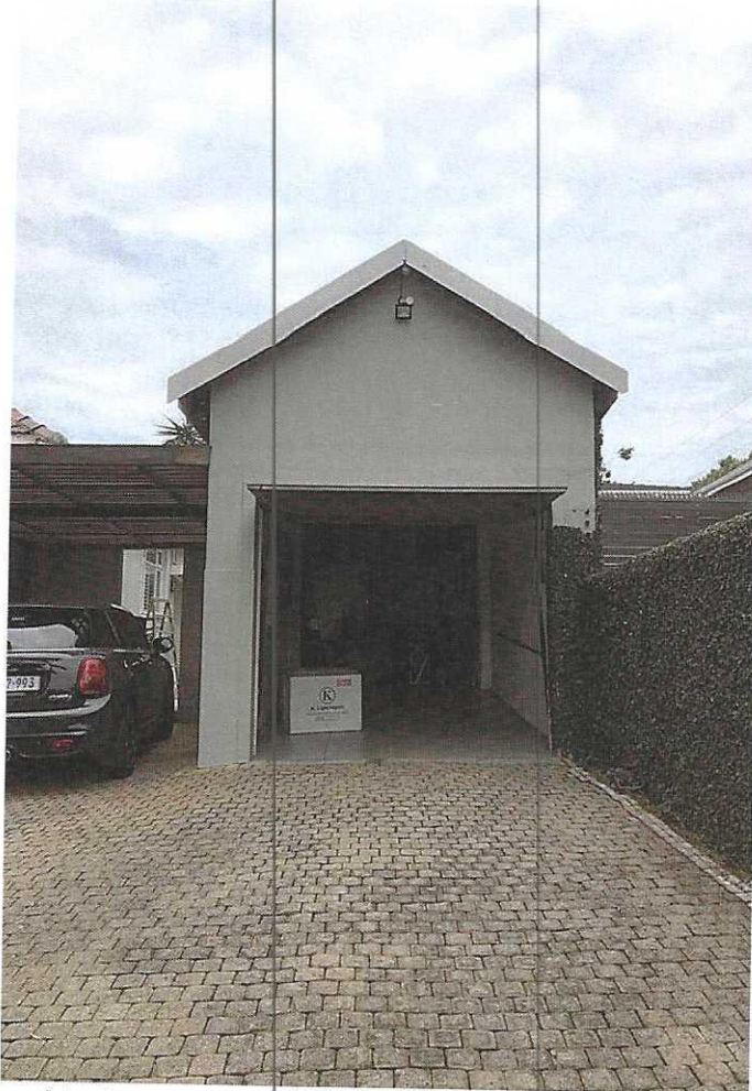
NORTH ELEU. - GARAGE
