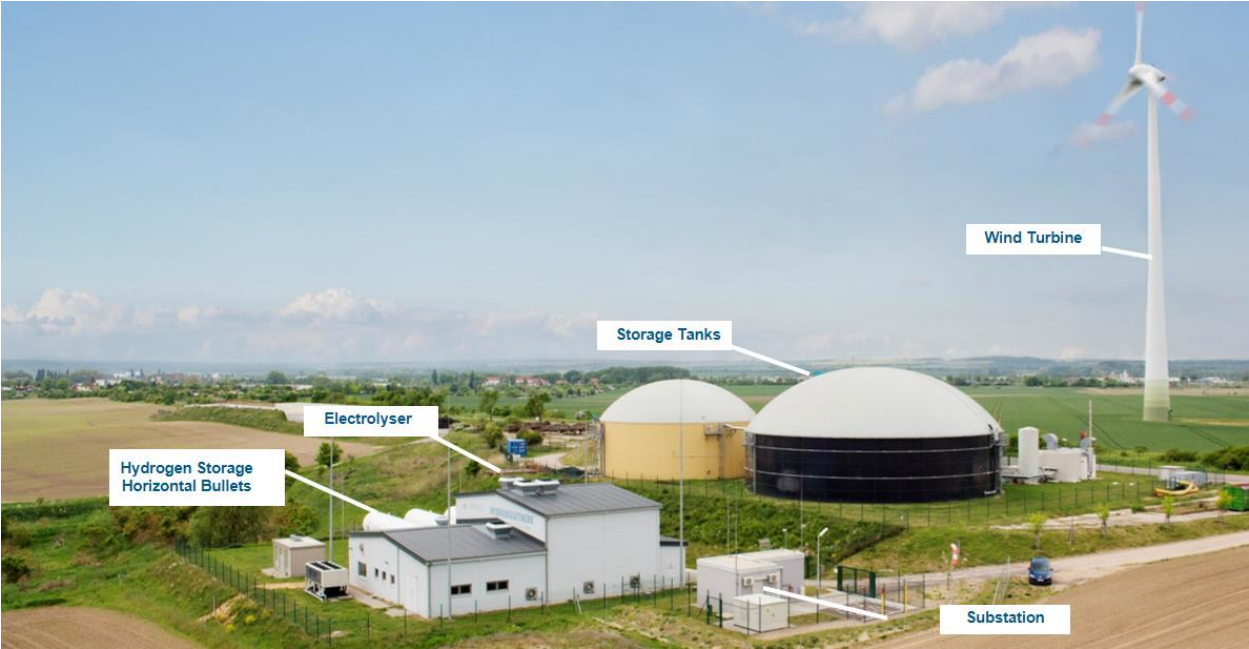
Figure 1: Enertrag Germany's Hybridkraftwerk.
