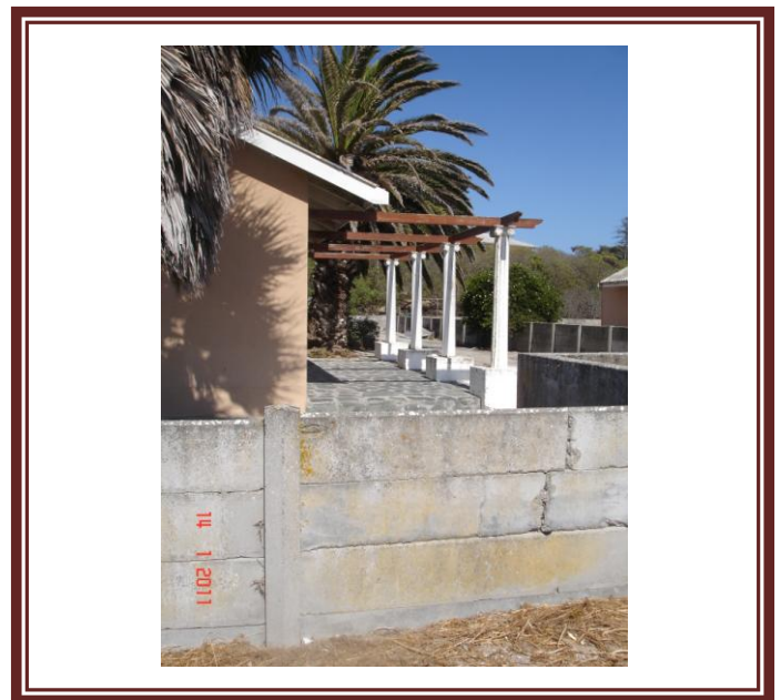
Fig.6.9. S face vibracrete
