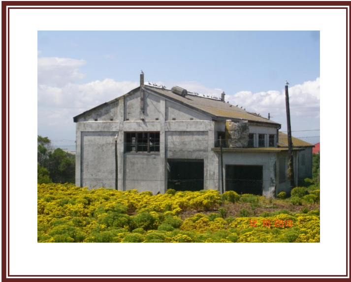
Fig.49. NE wood pole
