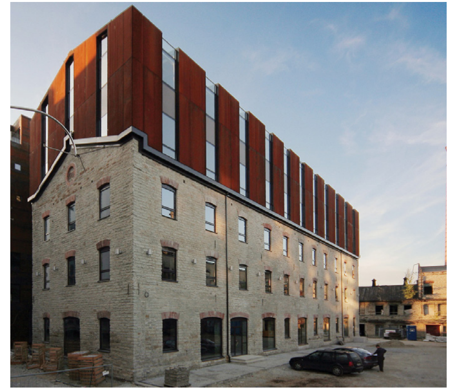
ROTERRMANN'S FLOUR STORAGE / HGA ARCHITEKTUUR
