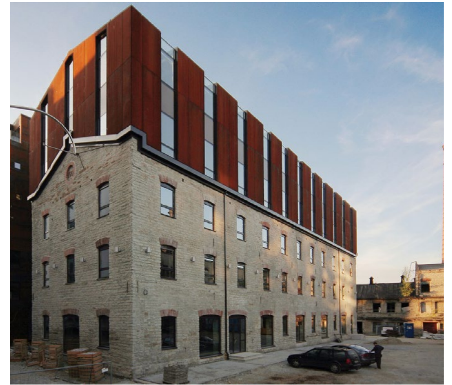
ROTERRMANN'S FLOUR STORAGE / HGA ARCHITEKTUUR
