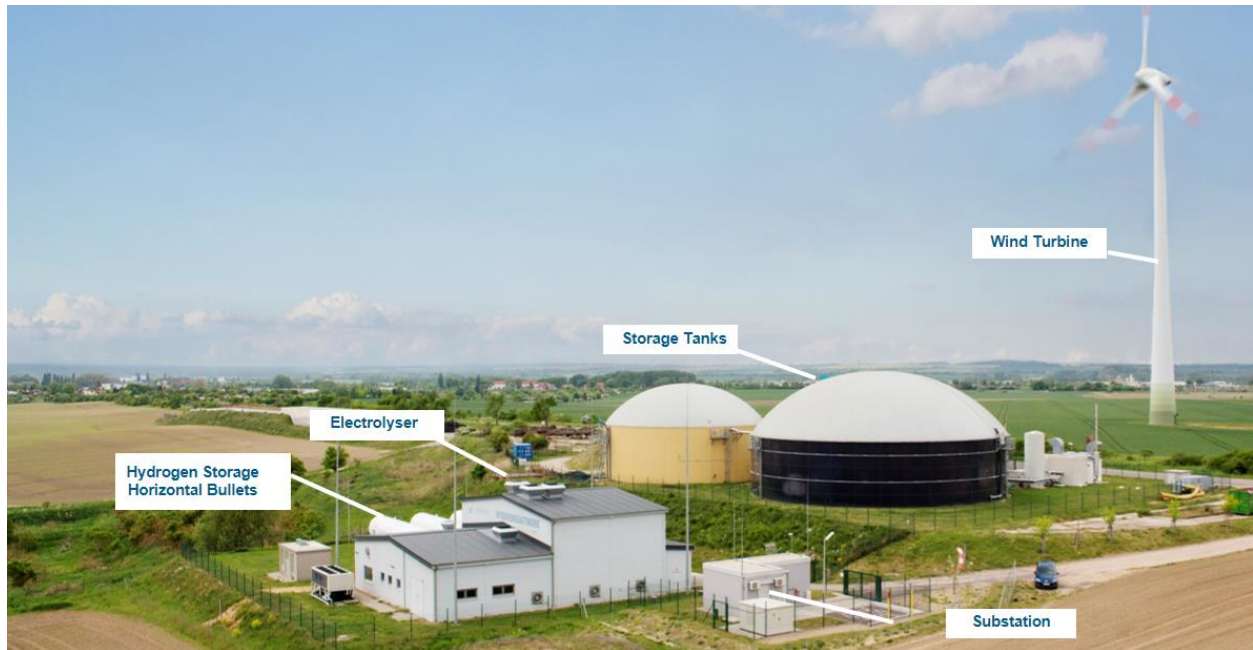
Figure 1: Enertrag Germany's Hybridkraftwerk.
