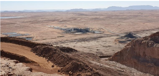
Figuur 3. Gamsberg-myn Bestaande Infrastruktuur
