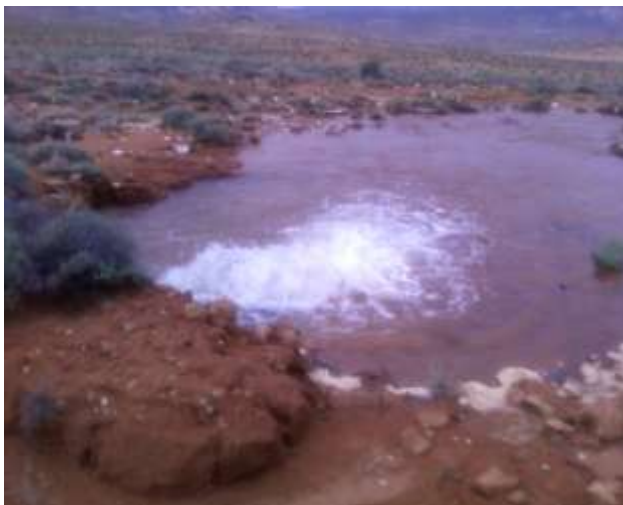
Typical pipe failure on the Eenriet to Vaalhoek gravity main
