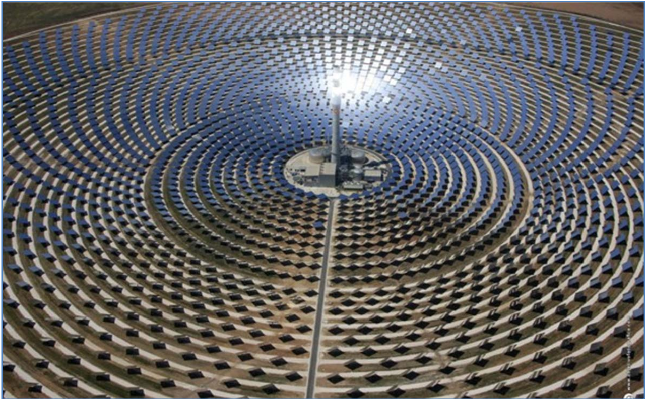
Figuur 3: Voorbeeld van 'n Gekonsentreerde Sonkrag (GS) Toring met omliggende sonkragpanele
