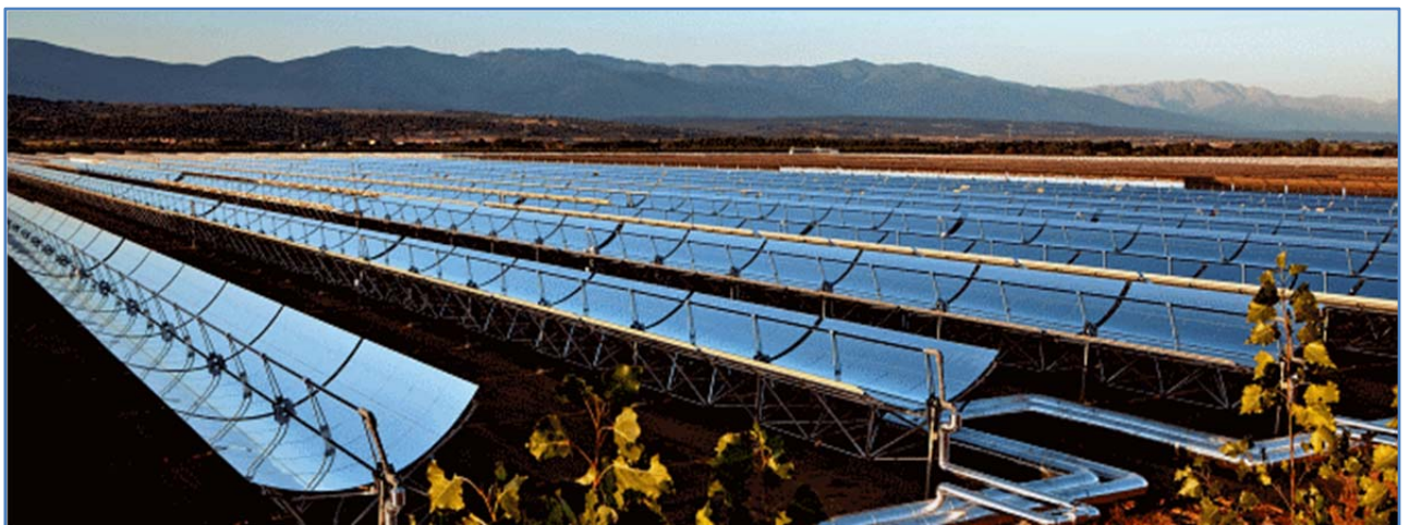
Figuur 2: Voorbeeld van 'n Gekonsentreerde Sonkrag Paraboliese Trog fasiliteit.
