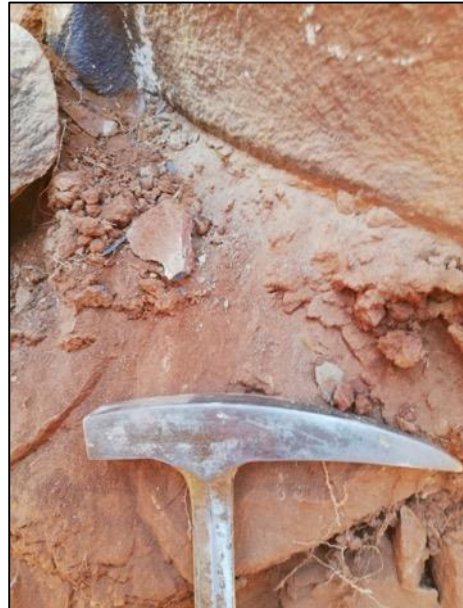
Test Pit no: TP07
