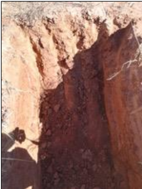
Test Pit no: TP07
