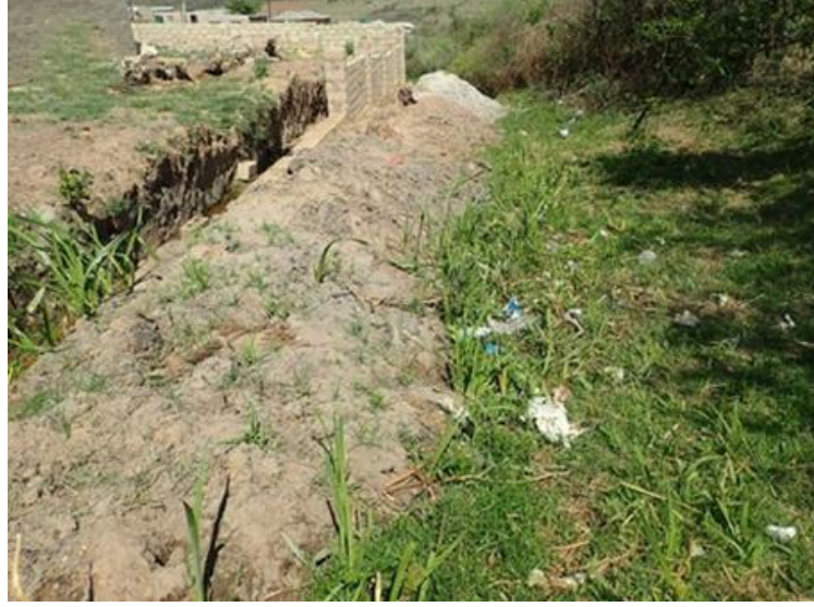
SITE PHOTO REFERENCE NUMBER: 4e
