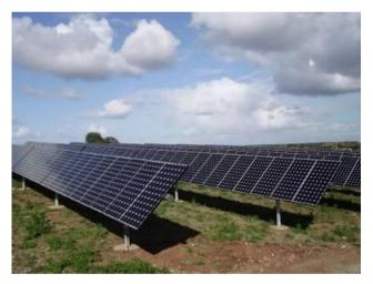
Die sonkragaanleg sal uit Fotovoltaïese (PV) panele bestaan, wat op vaste-kantel of roterende basis (wag op bevestiging), in n Noordelike rigting opgerig sal word. Gepaardgaande infrastruktuur sluit in 'n 132kV transmissie lyn, interne padnetwerk, minisubstasies en transformators.
