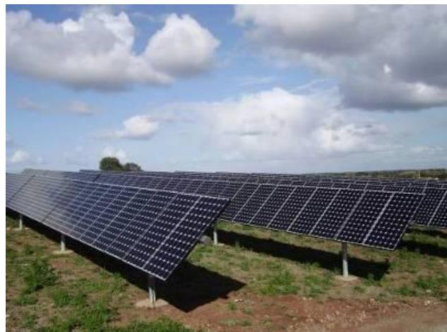
Die sonkragaanleg sal uit Fotovoltaïese (PV) panele bestaan, wat op vaste-kantel of roterende basis (wag op bevestiging), in 'n Noordelike rigting opgerig sal word. Gepaardgaande infrastruktuur sluit in 'n 132kV transmissie lyn, interne padnetwerk, mini-substasies en transformators.
