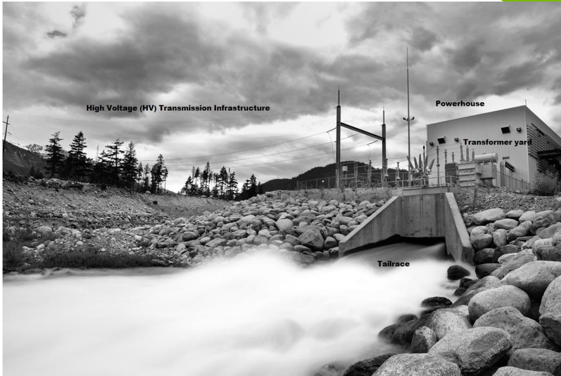
Figuur 5 | Voorbeeld van die kragentrale, transformatorwerf, transmissielyste en onderloop-infrastruktuur. Bron: http://www.photosensitive.com (Afgelaai: 28 Junie 2013)].
