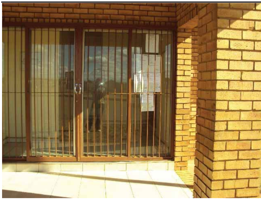
Photo 7 Site Notice Placement - Driefontein Thusong Centre
