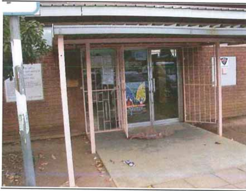
Photo 12 Site Notice Placement - Piet Retief Library
