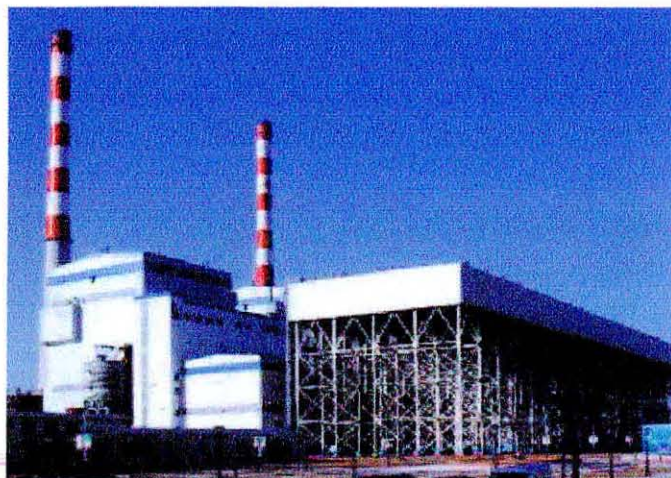
'n 200 MW Sirkuleerfluïedbe-kragstasie in China Bron: www.english.iet.cas.cn/research/ LaboratoryofCirculatingFluidizedBed/
