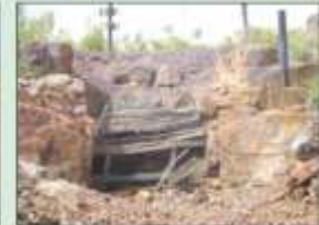
Figuur 4: Skag 3 in 'n vervalde toestand. Agter die houtbarkende beweik die skag 'n diepte van bykans 70m.
