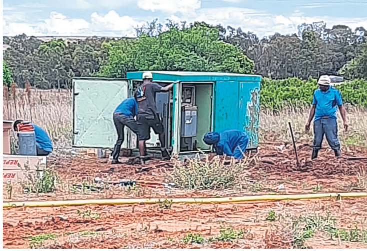
So lyk die elektrisiteitskabel van 64 m lank wat al drie keer in Pellissier gesteel is. Foto: VERSKAF
