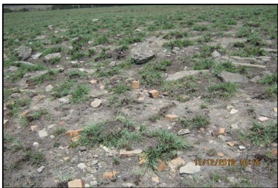
B03) Rubble (S27.121422; E29.771560).
