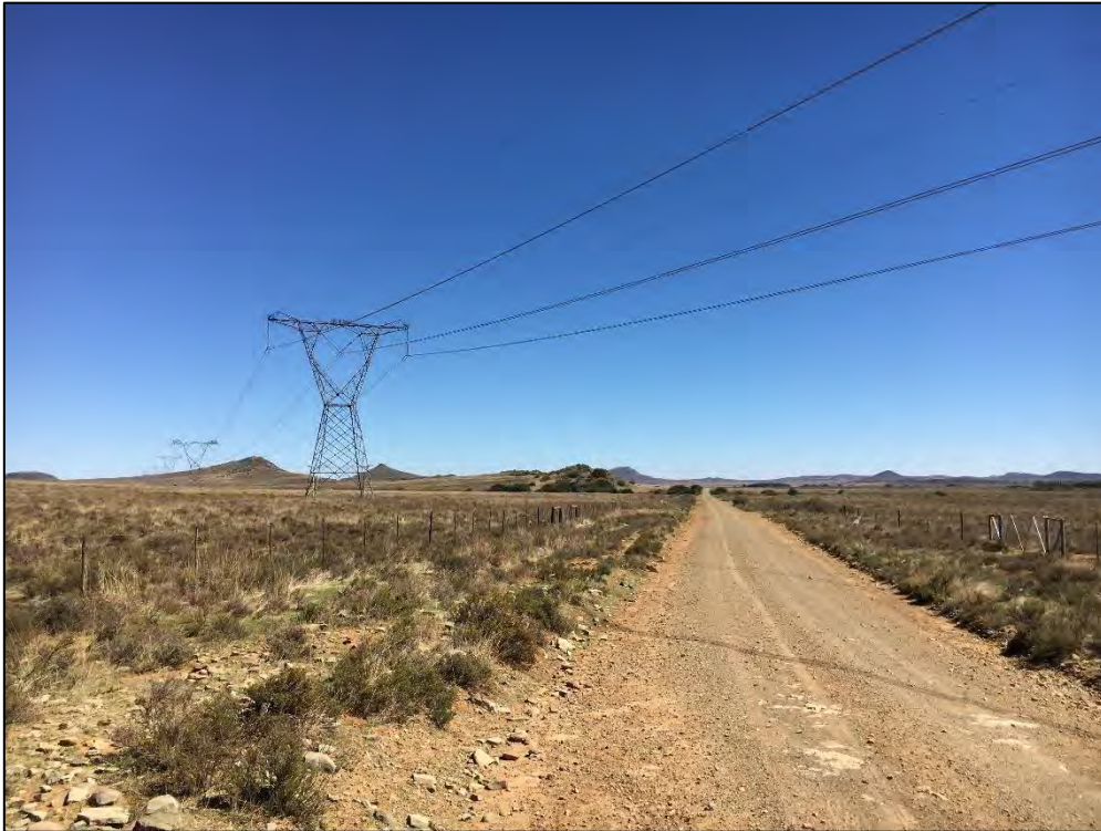
Figure 25: 400kV power lines traversing the Mooi Plaats solar PV application site.
