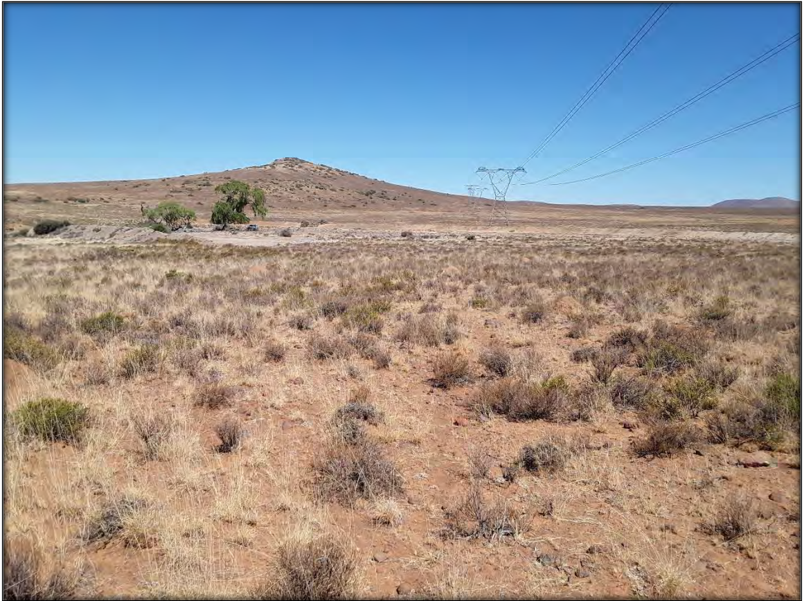
Figure 10: Existing power line on the development Mooi Plaats footprint 31° 16' 352"S 24° 45' 03"E
