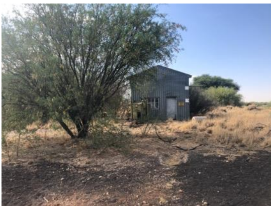
Figure 12 – Existing pumphouse at Middelpplaats shaft
