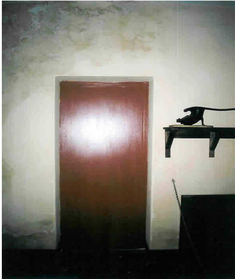
Figuur 58. Vals muur waarmee die opening tussen die manschappen en keukenvertrek toegemaak is.
