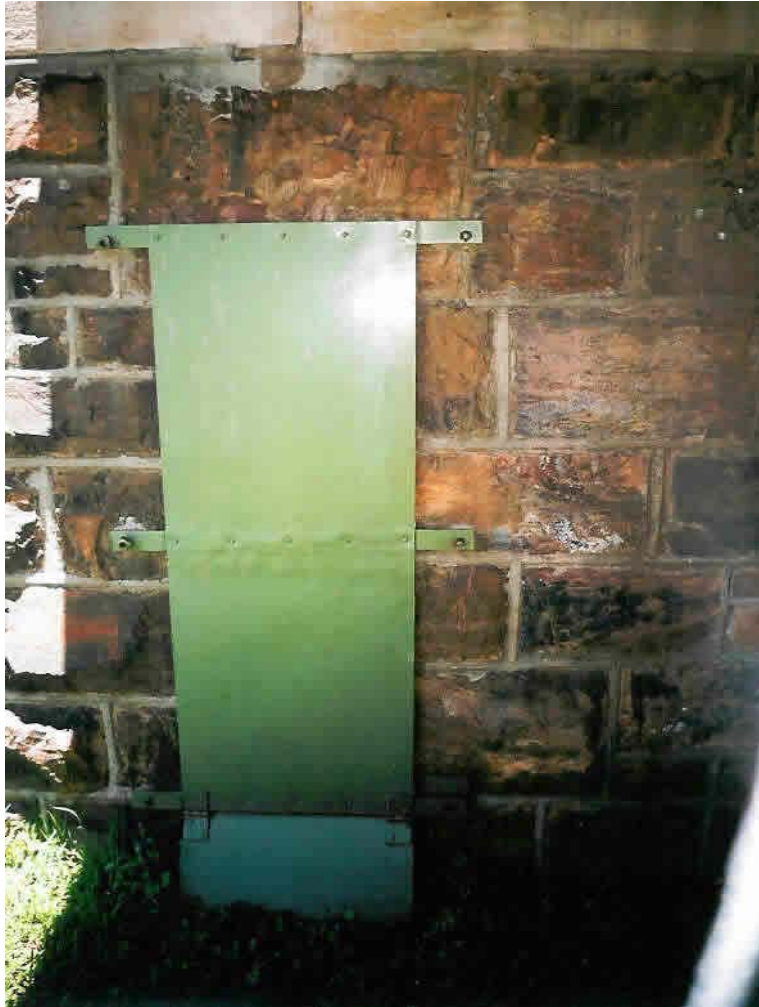
Figuur 88. Die staalplate onder die valbrug wat die katrolmeganisme versteek
