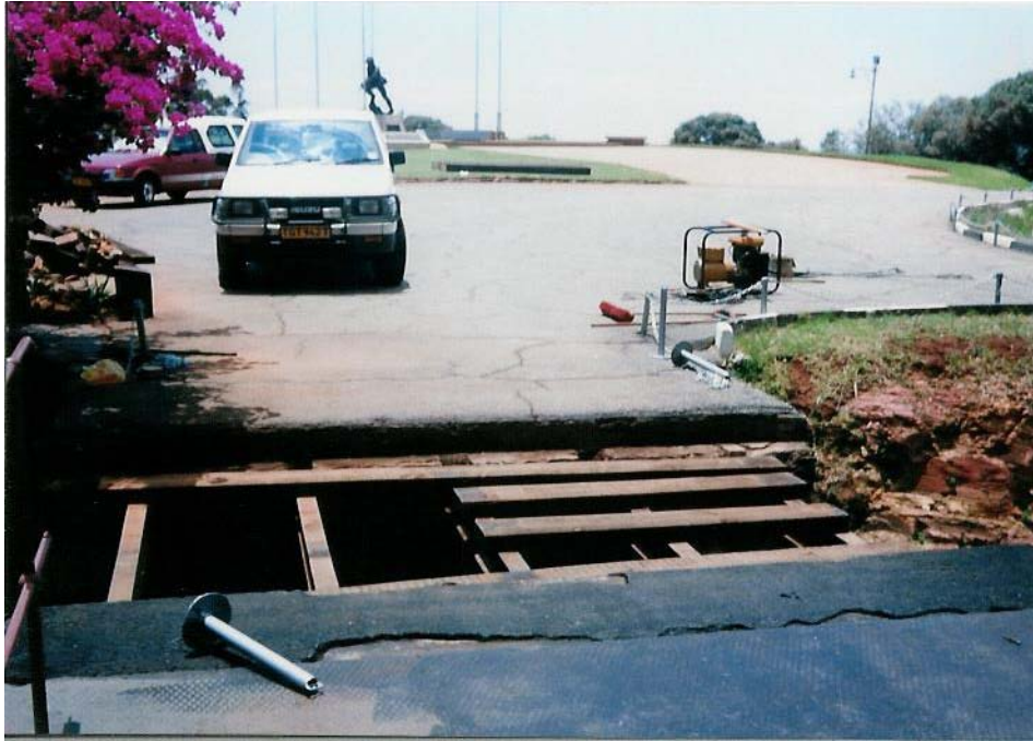
Figuur 89. Die onbeweegbare deel van die valbrug tydens restourasie
