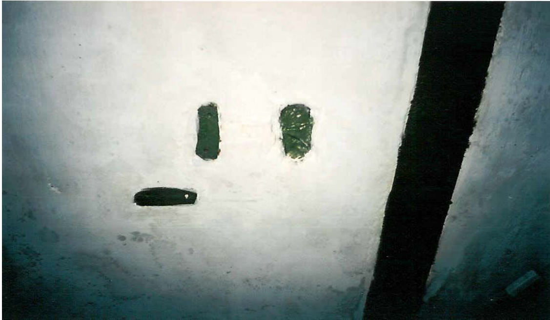
Figuur 28. Klampe waarmee die oorspronklike kragrade in die fort teen die plafon vasgemaak is.
