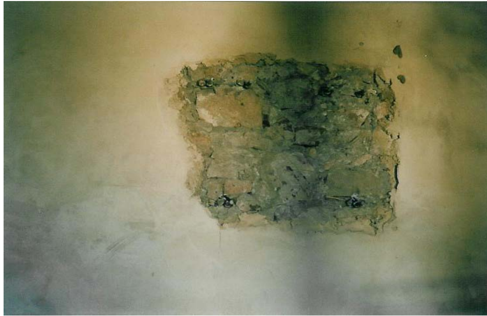
Figuur 45. Boute in die agterste muur by die machinevertrek, wat daarop dui dat hier iets vasgebout was.
