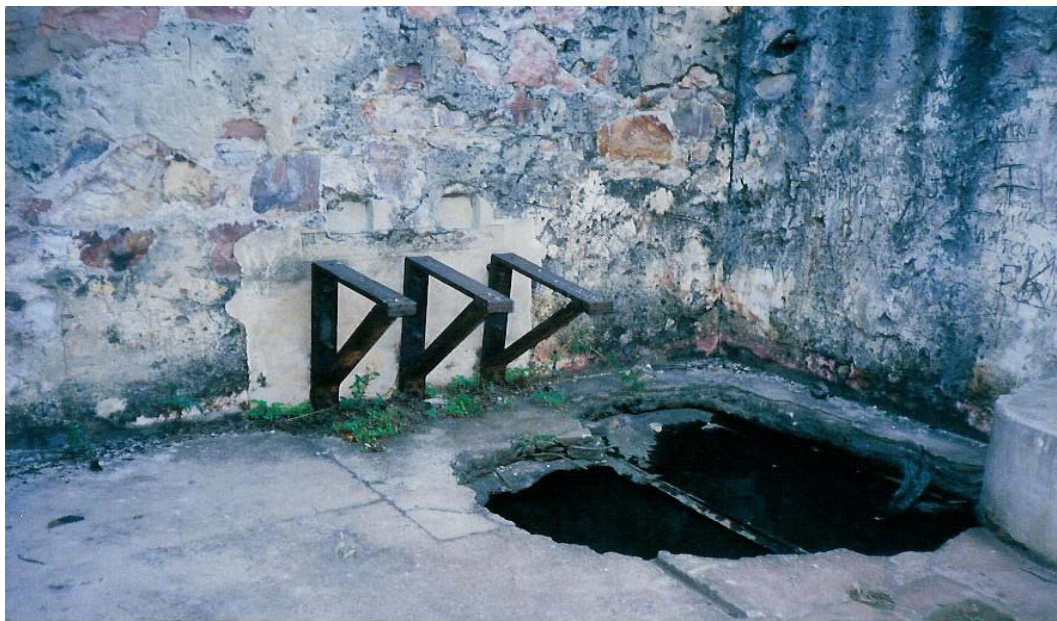
Figuur 46. Die machinevertrek by Fort Wonderboompoort. Let op die staalarme waarop iets gemonteer was en die tenks onder die vloer van die vertrek.
