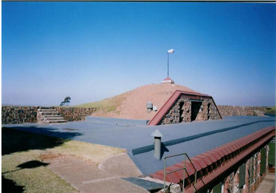
Figuur 94. Die oostelike gedeelte van die dak na restourasie
