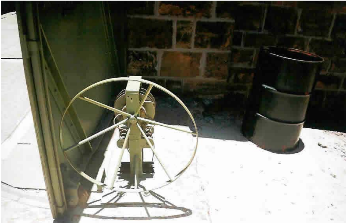
Figuur 87. Die wiel waarmee die valbrug beweeg word.
