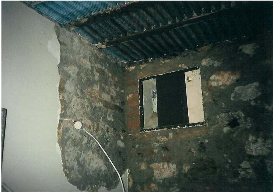
Figuur 73. Die plaatgaas is sigbaar by die plafon waar dit tussen die oorspronklike sink ingevoeg word. Dit is in die officierenvertrek.
