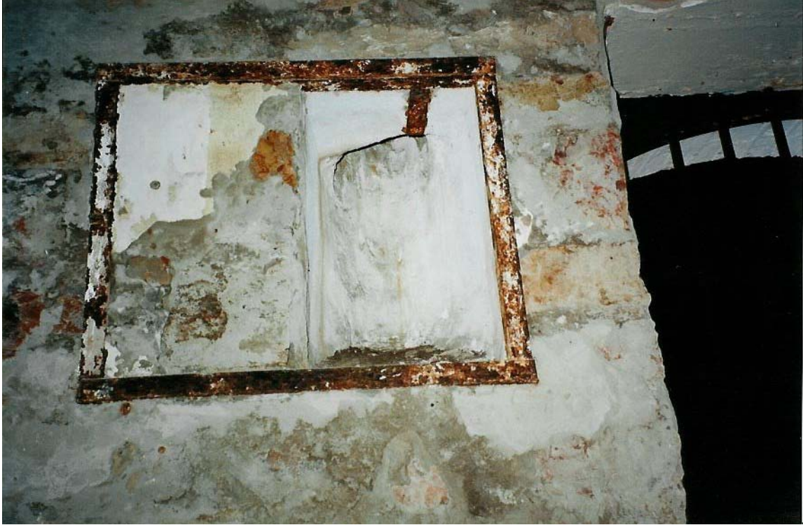
Figuur 55. Ventilasiëgate in die keukenvertrek. Die luik was verwyder maar is tydens restourasie vervang.
