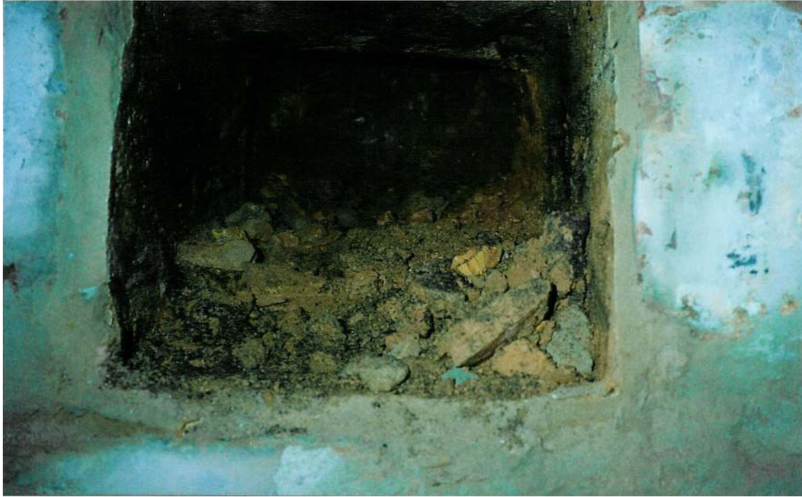
Figuur 54. Opening wat in die agterste muur van die vertrek gevind is en wat na verdere navorsing geblyk het die uitlaat vir die stoof se skoorsteen te wees.
