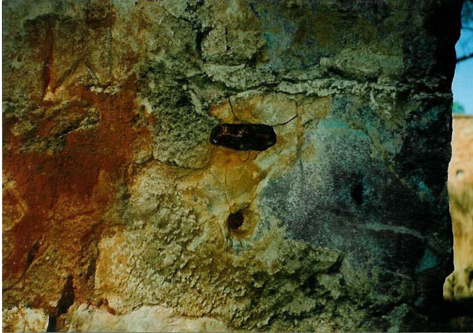
Figuur 38. Metaalklamp in die telegraafvertrek by Fort Wonderboompoort wat gebruik is om die elektriese drade te gelei.
