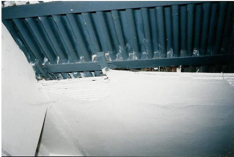
Figuur 79. Oorspronklike sinkplafon in die Stalvertrek by Fort Wonderboompoort
