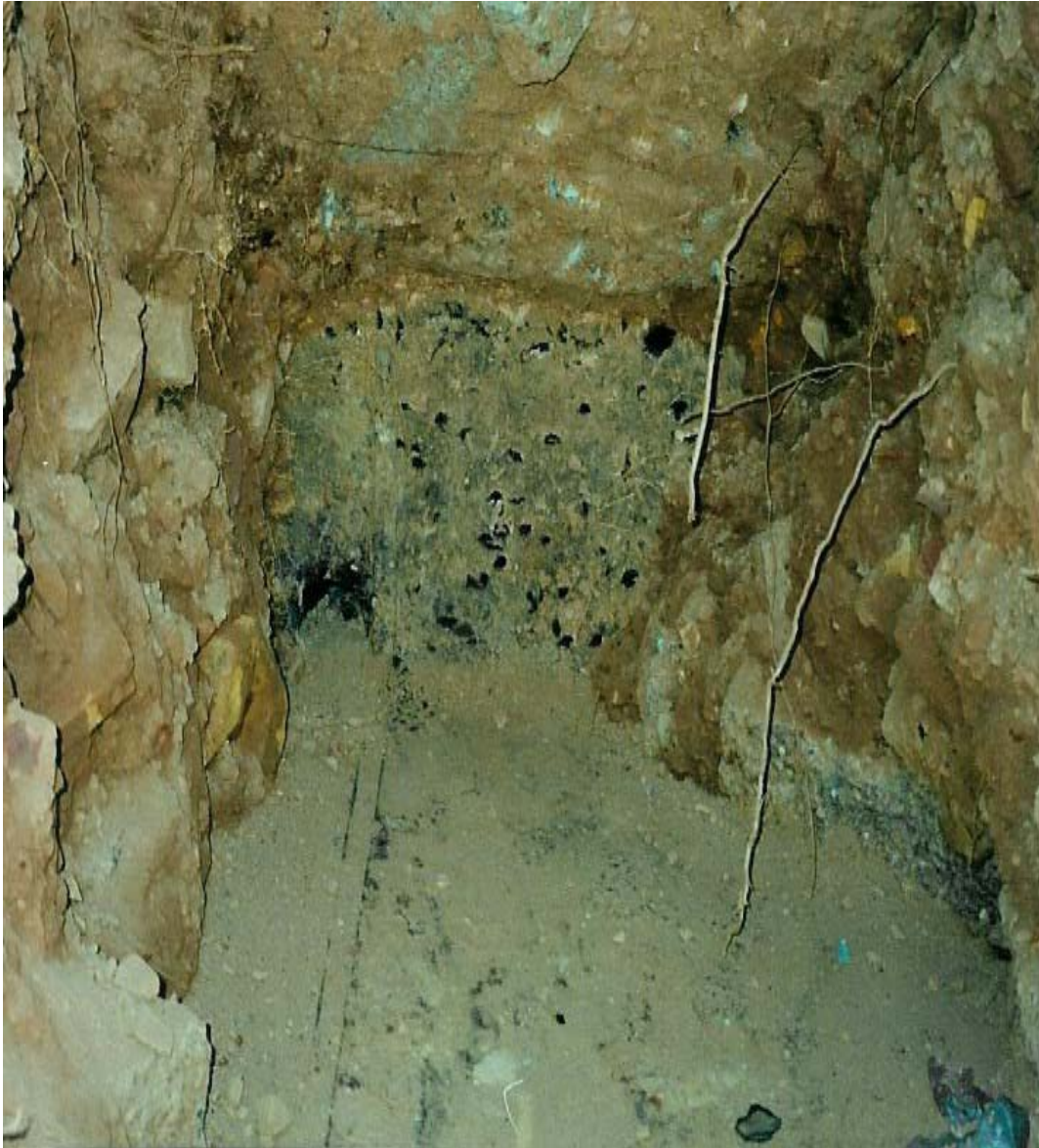
Figuur 91. Detail van die waterdigting op die dak van die fort.
