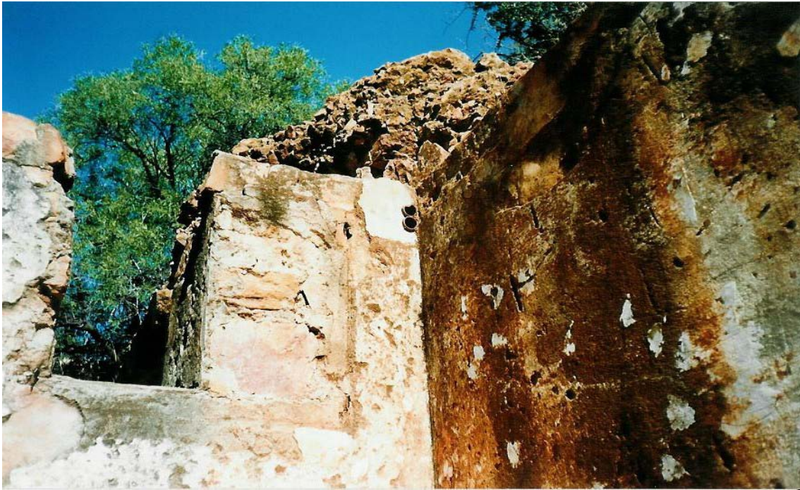
Figuur 30. Metaalpipe in die mure by Fort Wonderboompoort wat gebruik is om die elektriese drade te gelei.
