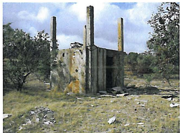
Figure 20. Onverwacht 2 water tank
