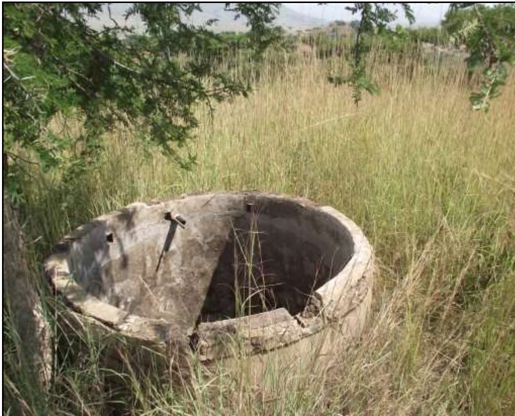
Fig. 10. Site CLB 8. A concrete dam.
