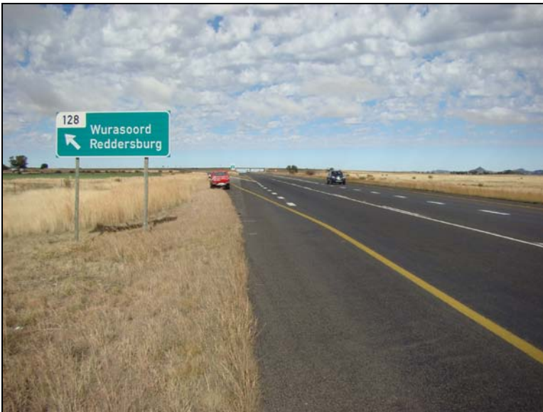
Fig.6 N1 Section 14, Wurasoord exit 128.
