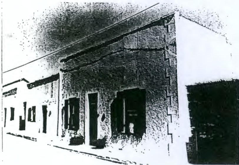
287. Erf 308: 28 Bell Street.
