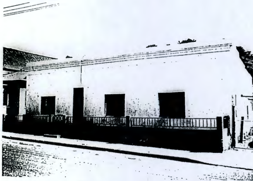
11. Erven 380 & 381: 26 Stockenstrom Street.
