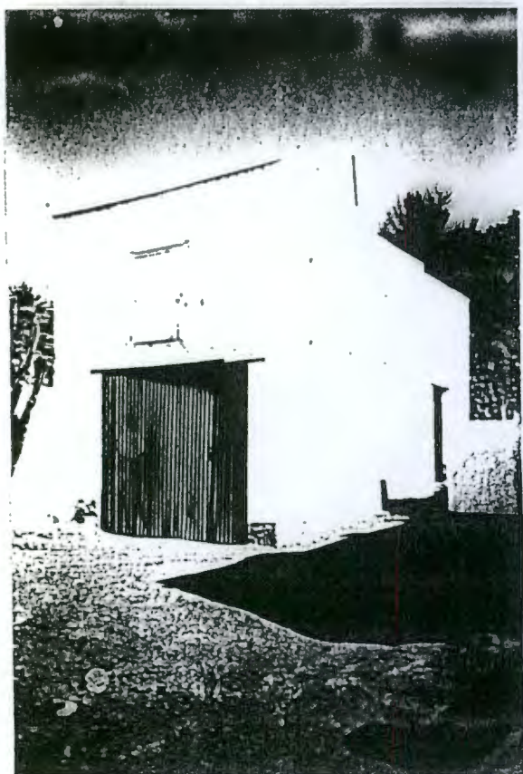
6. Erven 366, 367 & 368: Garage, 36 Stockenstrom Street.
