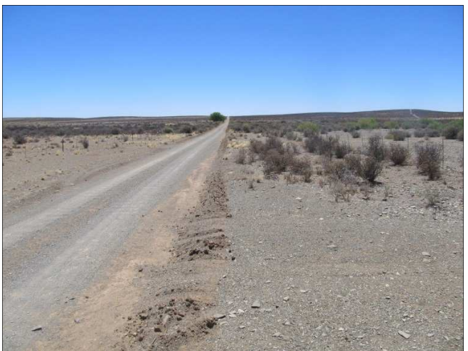
Figure 21. View along OG 86.
