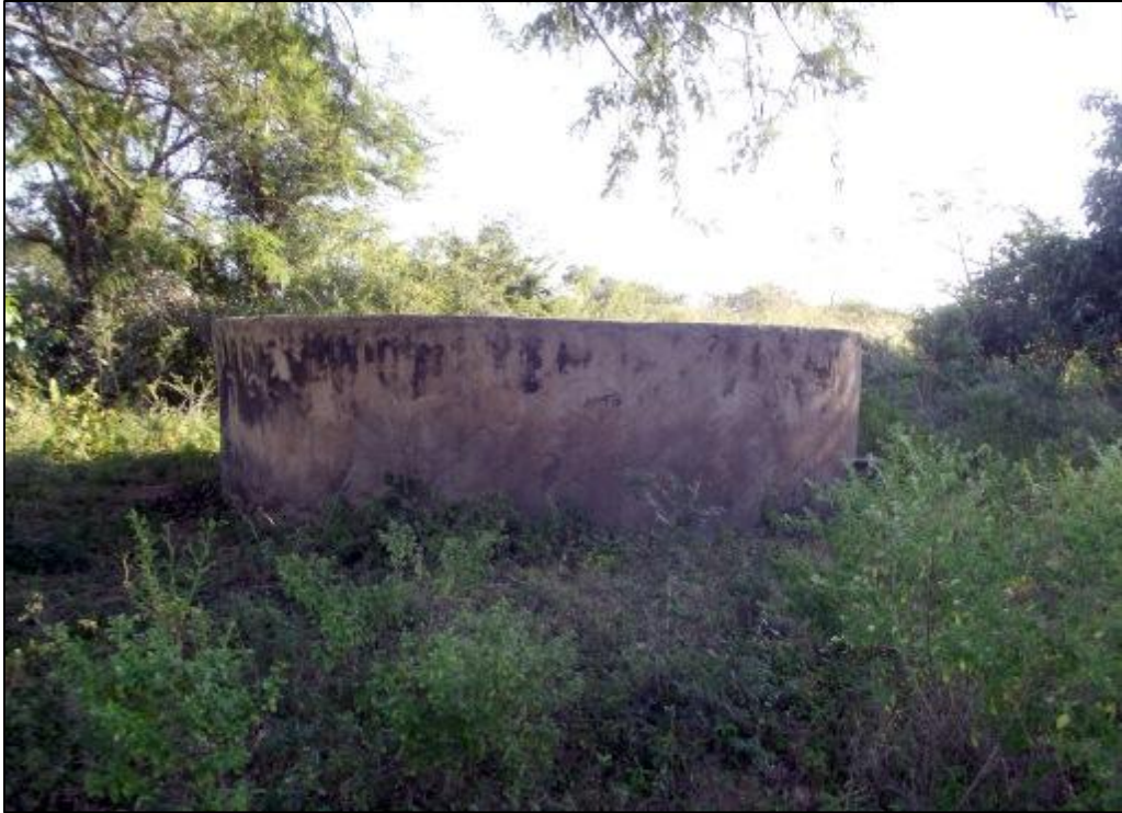
Fig. 3. Kasteel site BC 1. A concrete dam.
