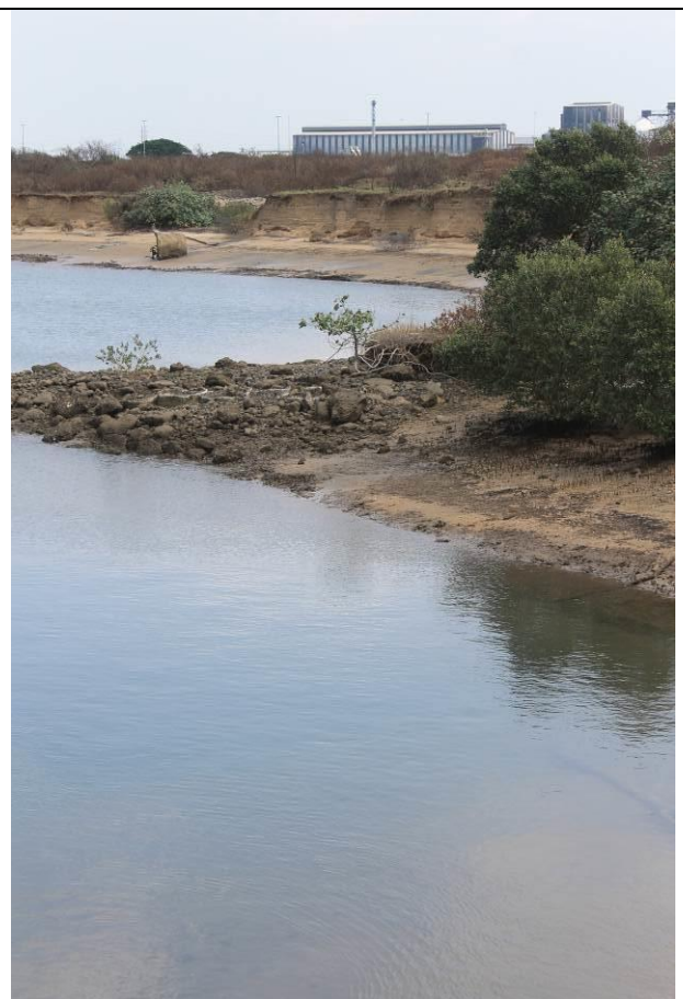
J Eroded water edge
