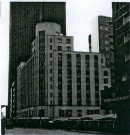
Avril Malan Building (6.1.3.3.14).
