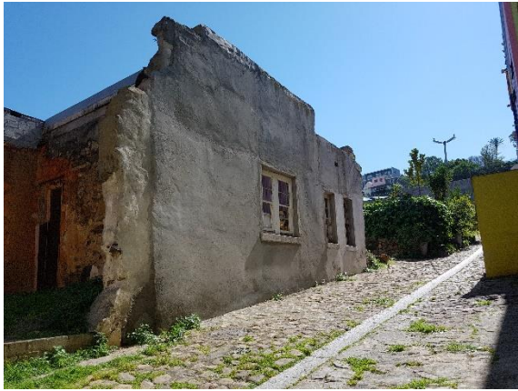
Berg Lane façade
